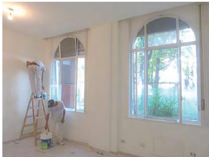
Renovación de las capas pictóricas dañadas en Sala de reuniones en Planta Baja. (Fuente: Martín Capeluto / MSME)
