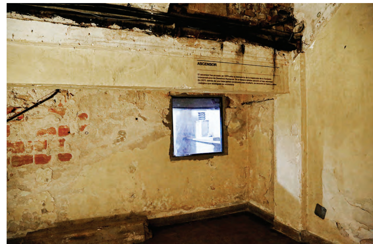
Sala Sótano. Huevo abierto en el muro para inspeccionar las marcas constructivas de la existencia del ascensor. El hallazgo se dejó visible y protegido mediante la colocación de un vidrio. (Foto 32: Camilo del Cerro / MSME)
