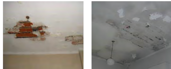
Desprendimiento y oxidación del recubrimiento de las armaduras de las losas en sectores de Planta Baja. (Fuente: Martín Capeluto / MSME)
