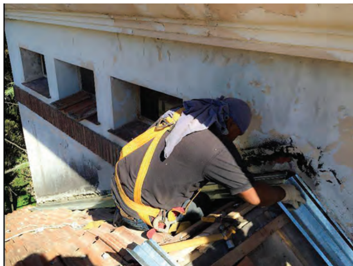
Recuperación de la estanqueidad de las cubiertas mediante ejecución de detalles de zinguería en tejados. (Fuente: Martín Capeluto / MSME)
