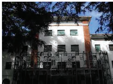
Fisuración y desprendimiento del revoque en dintel de vano en Planta Segunda, sobre eje del cuerpo central de la fachada principal. (Fuente: Martín Capeluto / MSME)
