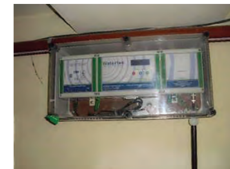
Componentes del sistema de control de humedades ascendentes por electroósmosis inversa colocado en Planta Sótano. (Fuente: Martín Capeluto / MSME)
