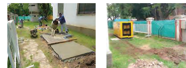
Ejecución de platea para el posicionamiento del grupo electrógeno. (Fuente: Martín Capeluto / MSME)
