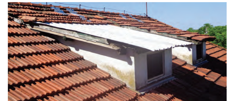
Estado de los tejados, previo al inicio de las obras de 2012. (Fuente: Lucía de Lisi)
