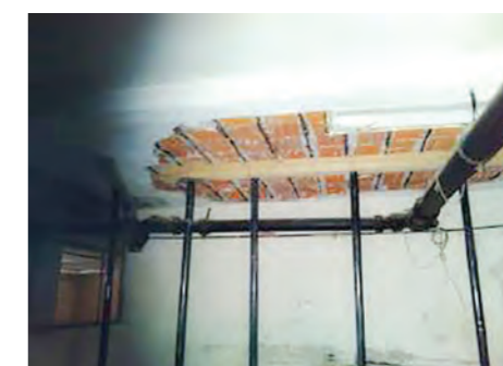
Instalación termomecánica: limpieza y renovación parcial de conductos para su reutilización, y colocación de nuevos equipos. (Fuente: Martín Capeluto / MSME)
