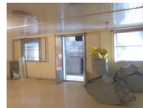
Instalación termomecánica: limpieza y renovación parcial de conductos para su reutilización, y colocación de nuevos equipos. (Fuente: Martín Capeluto / MSME)
