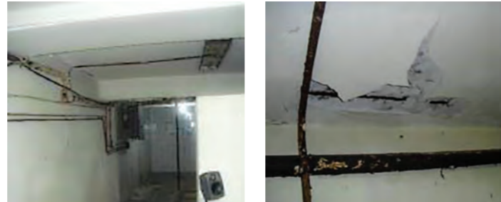
Desprendimiento de recubrimiento de las armaduras y oxidación en losa en Planta Sótano, bajo hall principal. (Fuente: Martín Capeluto / MSME)
