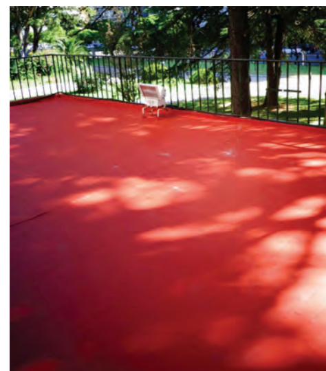
Colocación de membranas hidrófugas sobrepuestas, sin retiro de material original, en las terrazas accesibles (izquierda), y en las terrazas de servicio (derecha). (Fuente: Lucía de Lisi)
