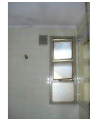
Desajustes en las carpinterías exteriores en una habitación de Planta Primera (izquierda) y en ventana de un baño en Planta Primera (derecha). (Fuente: Martín Capeluto / MSME)
