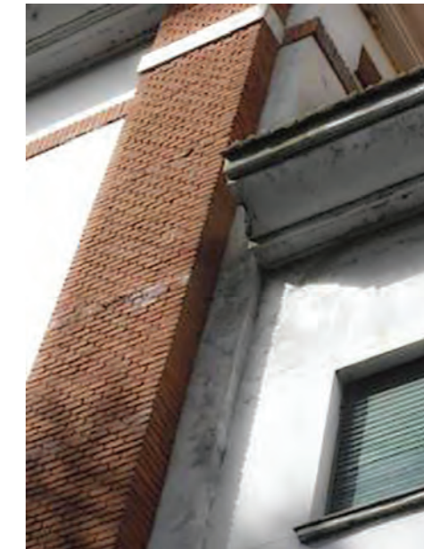
Fisuras horizontales en el revestimiento de ladrillo visto sobre la fachada principal, en la intersección de los volúmenes central y laterales. (Fuente: Martín Capeluto / MSME)
