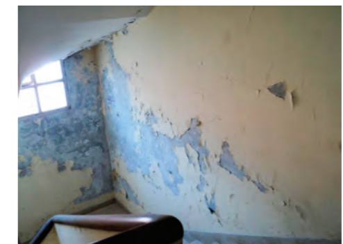
Superficies arquitectónicas interiores: antes (arriba e izquierda) y después (derecha) de los tratamientos limpieza y consolidación. (Fuente: Martín Capeluto / MSME)
