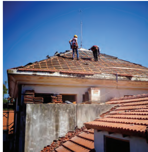
Recuperación de materiales (tejas, cabios y entablado de madera) y reemplazo selectivo de los materiales dañados. (Fuente: Lucía de Lisi)
