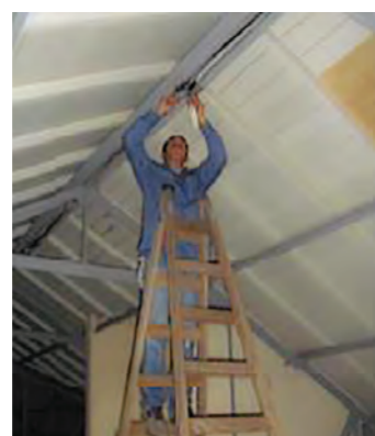
Artefactos del sistema iluminación: detalle del desmontaje, clasificación y limpieza de las luminarias para su posterior colocación en "Capucha" y en el Salón Dorado. (Fuente: Martín Capeluto / MSME)
