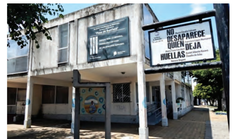
Espacio para la Memoria "Pozo de Banfield". (Fuente: Agencia Télam)
